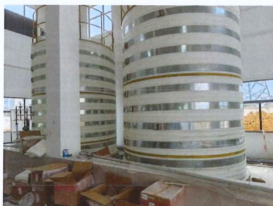
储罐设有围堰，有效防止泄漏
