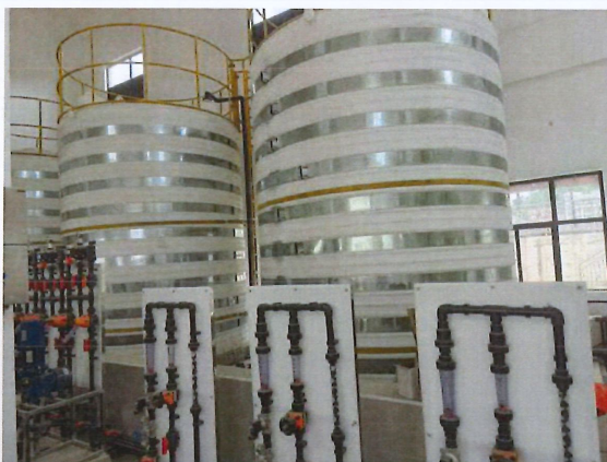
储罐设有围堰，有效防止泄漏
