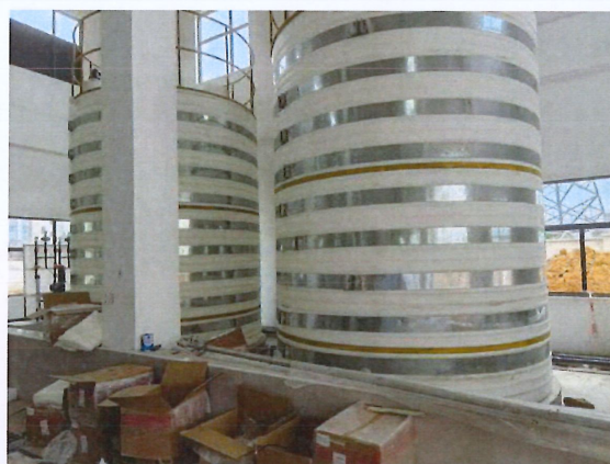
储罐设有围堰，有效防止泄漏
