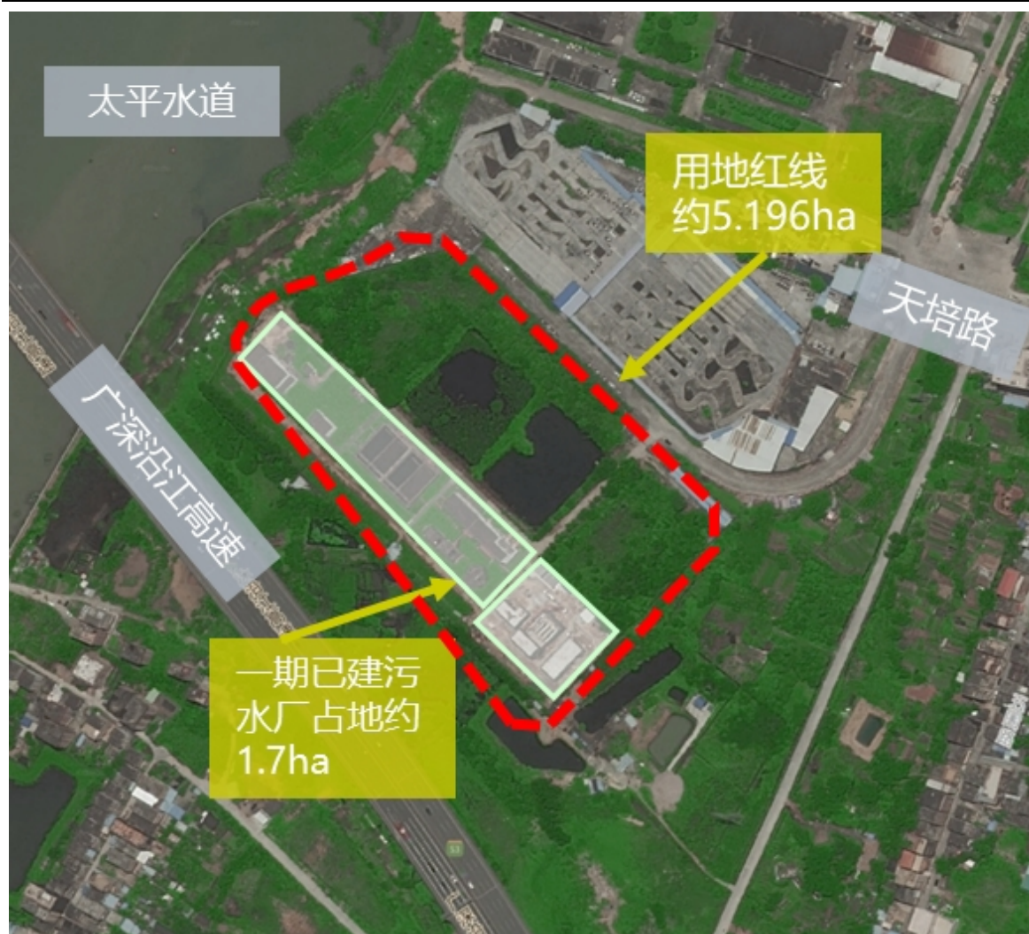
图 4.6-1 海岛水质净化厂现状用地情况
