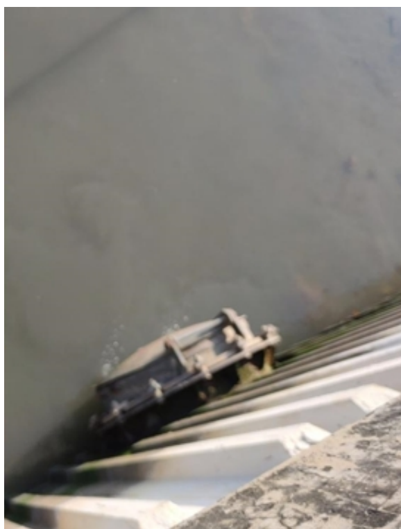
图 2.2-7 W109 排口现场照片
